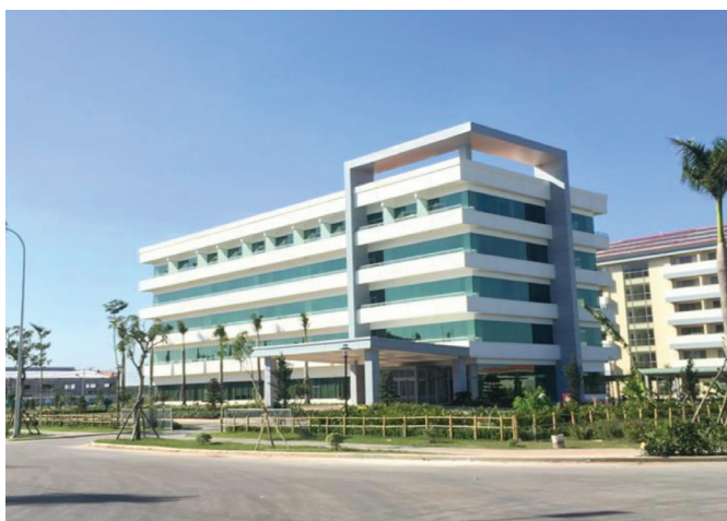
Cung cấp sơn và thi công sơn công trình trụ sở Vsip - Nghệ An
