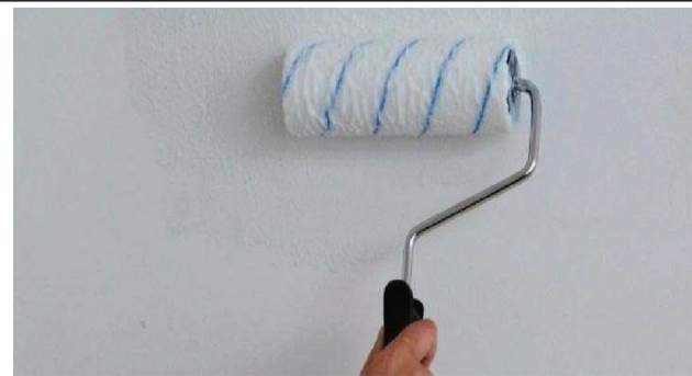
3) Thi công lớp lót Stone Sealer
