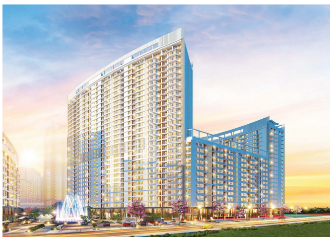
Cung cấp sơn và thi công sơn công trình dân dụng
