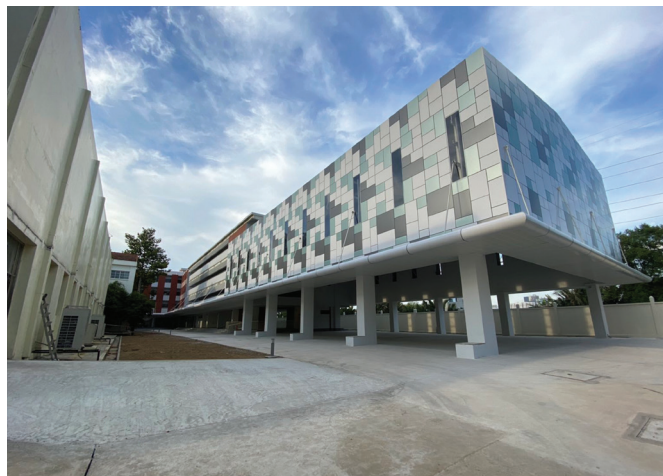
thi công sơn công trình trụ sở làm việc công ty Hosiden - Bình Dương
