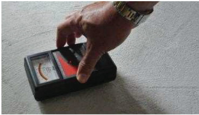
1) Vệ sinh tường vữa trát và kiểm tra độ ẩm bề mặt
