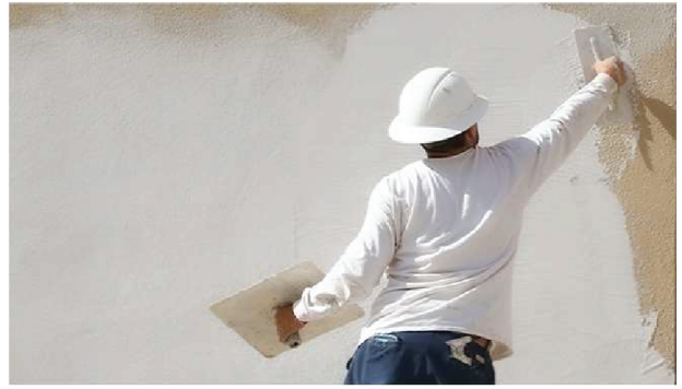
2) Thi công Stone texcoat
