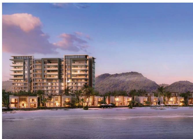
Cung cấp sơn và thi công sơn công trình INTERCONTINENTAL HA LONG
